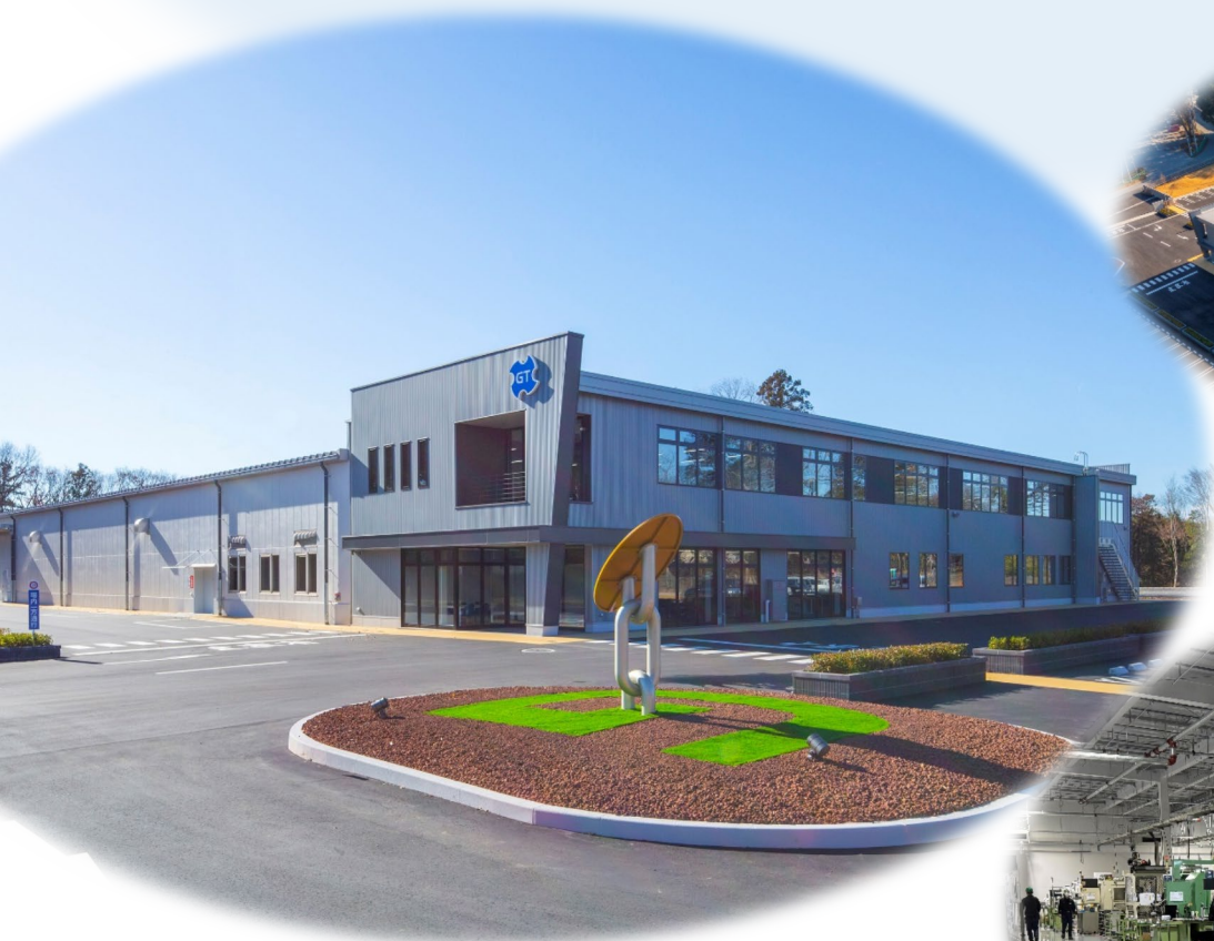
新工場（正面入口）
