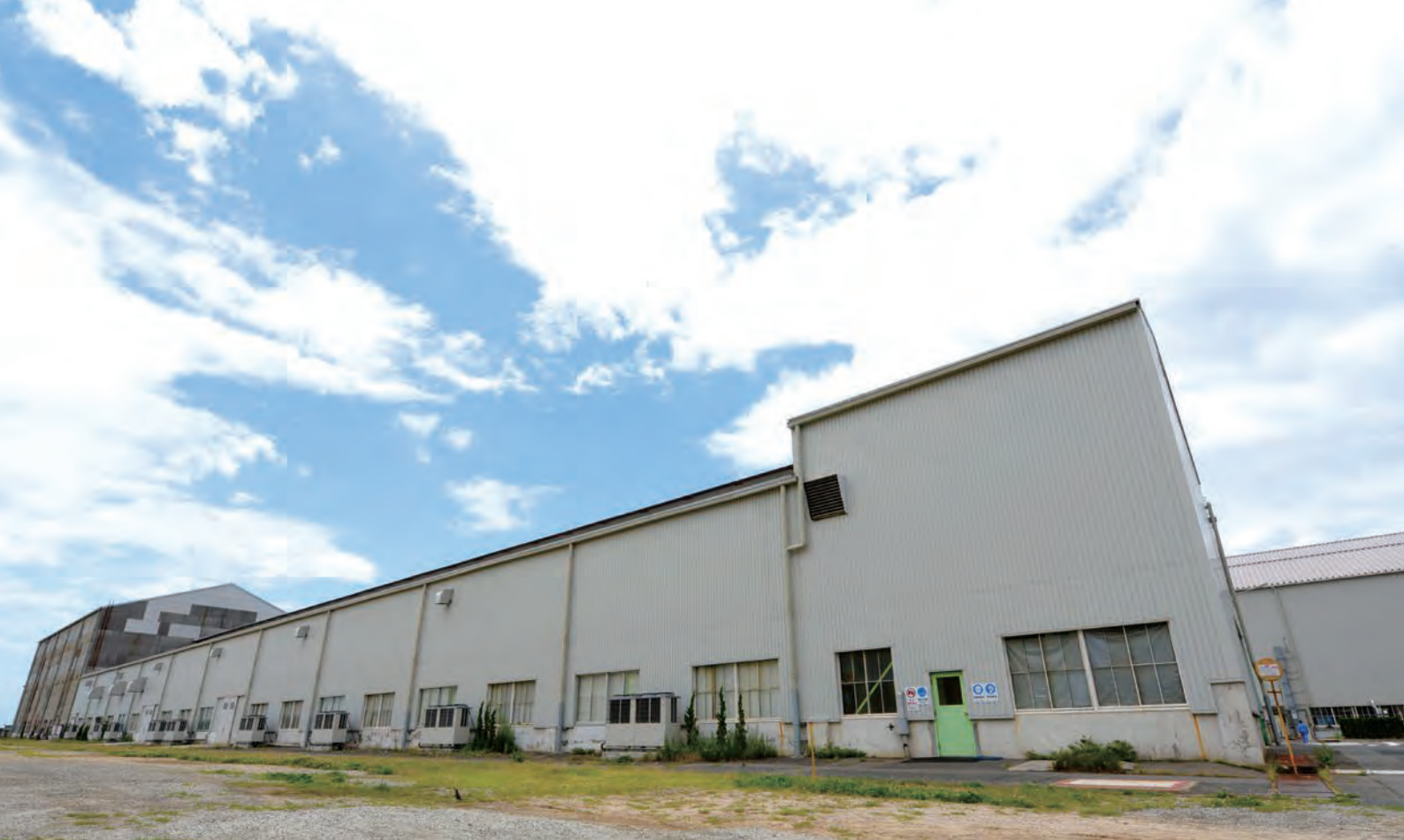
MHI 江波工場 - 機械部品工場
